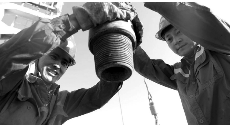
西部钻探准东钻井公司工人进行钻井作业。
