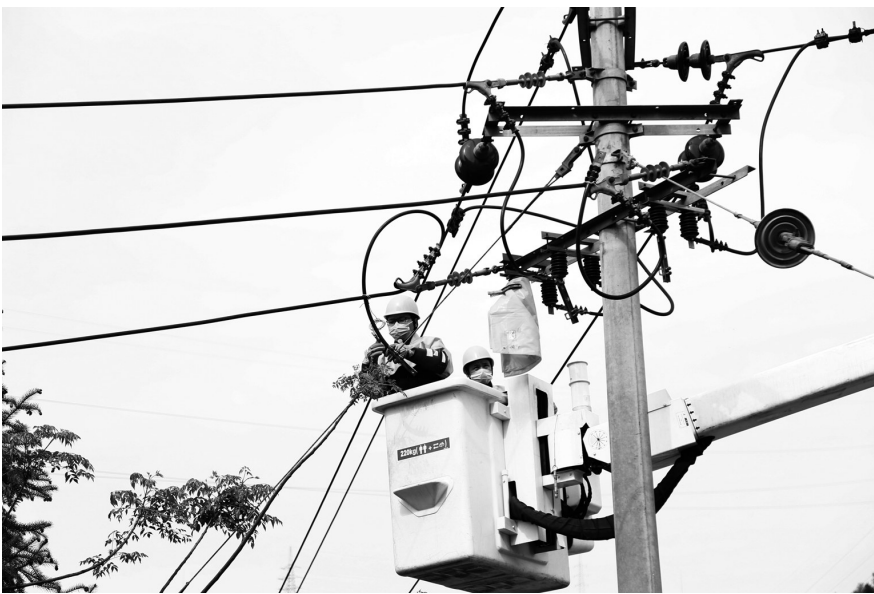
建阳供电公司运用带电作业，检修塔下工业园区10千伏线路，助力企业复工复产。 通讯员 蔡蓓婕摄
