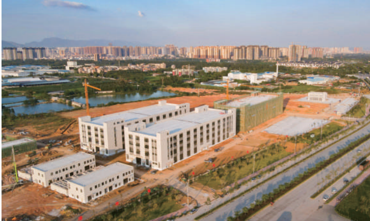
在建的贵港市电子电路产业鲤江园
