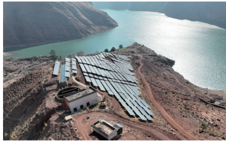
光伏提水项目光伏板铺设地
