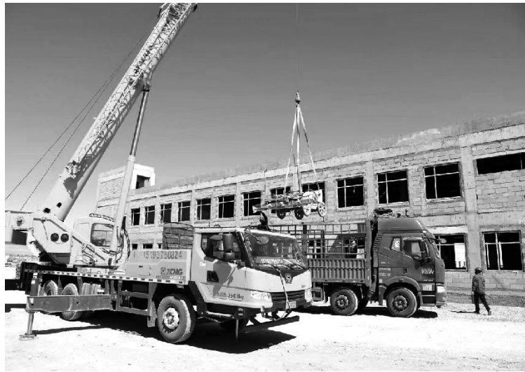
甘肃省西部华研工业防腐剂防霉剂中间体及制剂项目建设现场 通讯员 杨棋摄
